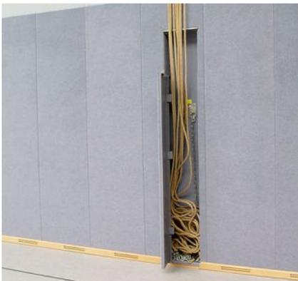
Die Ringe sind bei Nichtgebrauch hochzuziehen und die Seile sind zu arretieren. Die Höhenverstellereinrichtung ist bündig zur Hallenwand einzubauen. Dies kann z. B. durch Einbauten in Nischen erfolgen.
