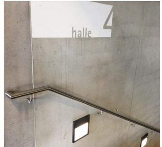
Handläufe sind so auszubilden, dass ein Hängenbleiben an ihnen ausgeschlossen werden kann. Dies wird erreicht, wenn sie keine freien Enden aufweisen. Das Ende des Handlaufs kann z. B. mit einem Viertelkreis abgerundet und zur Wand abgewinkelt ausgebildet werden.
