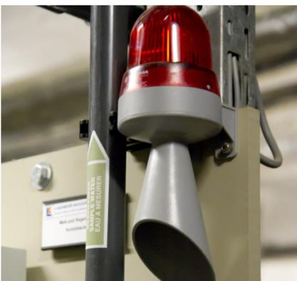
Chlorgasräume sind durch ein geeignetes Chlorgaswarngerät mit akustischer und optischer Signalgebung zu überwachen. Dieses hat einen Chlorgasaustritt durch ein akustisches Warnsignal anzuzeigen. Bei einem Chlorgasausbruch muss zusätzlich ein optisches Warnsignal am Chlorgasraum aufleuchten, z. B. als Rundum- oder Blinkleuchte.
