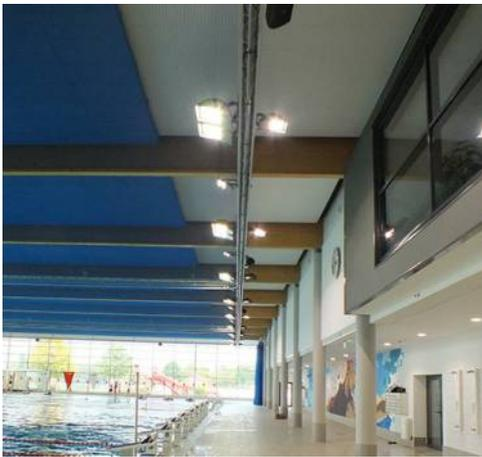
Über Wasserflächen dürfen keine Leuchten angeordnet werden. In der Praxis hat sich deren Anordnung parallel zu den Längsseiten der Becken bewährt. Darüber hinaus müssen sämtliche Beleuchtungen in Ballspielbereichen ballwurfsicher installiert werden.
