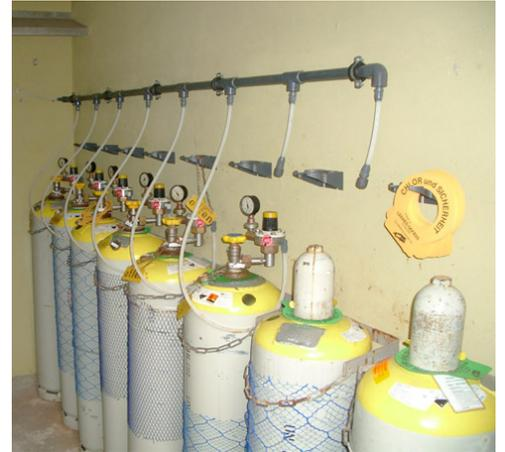
Chlorungsanlagen müssen Einrichtungen haben, die bei unzureichendem Durchfluss oder bei Stillstand des zu chlorenden Wassers oder Messwassers die Zufuhr der Chlorungschemikalien selbstständig unterbrechen.
