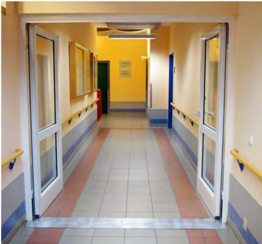
Diese Türen müssen selbstschließend, d. h. mit Türschließern, ausgeführt werden, um den Raucheintritt in benachbarte Bereiche zu verhindern. Zusätzlich müssen sie jederzeit auch von Hand geschlossen werden können.
