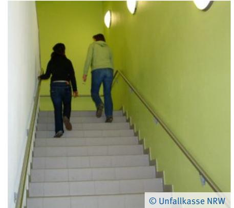
**Treppen** allein sind keine barrierefreie vertikale Verbindung. Höhendifferenzen können nur durch **Rampen** oder **Aufzüge** barrierefrei überwunden werden. Durch die Einhaltung der unter dem Symbol der Barrierefreiheit aufgeführten Anforderungen können Treppen von Menschen mit motorischen Einschränkungen sowie von blinden und sehbehinderten Menschen besser benutzt werden.
