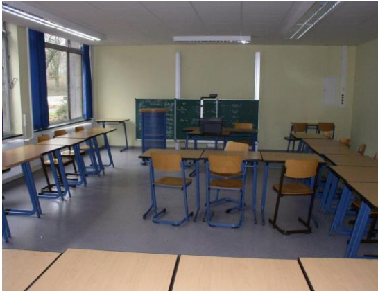
Abb. 1: Akustikdecke, geputzte Wände und Linoleum Fußboden; Foto: M. Buxtrup, UK NRW
