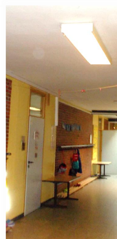
Abb.13: Flur mit Betonboden, zum Teil verklebten und geputzten Wänden sowie einer Betondecke (Alles schallharte Materialien). Foto: U. Feder, UK NRW
