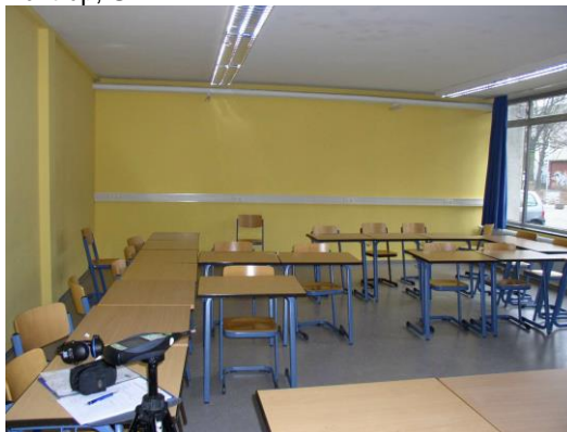
Abb. 12: Geputzte Wände mit Maurermörtel Foto: M. Buxtrup, UK NRW
