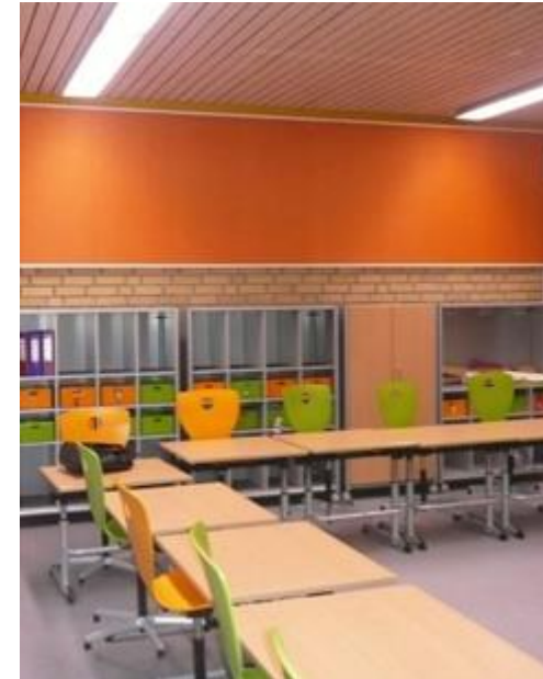
Abb.: 9: Akustikdecke und Akustikelemente im oberen Deckenbereich Quelle, DGUV Regel 102-601 „Branche Schule“ https://publikationen.dguv.de/widgets/pdf/download/article/3581
