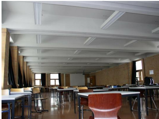
Abb. 10: Schallharte Betondecken mit Deckenstürzen. Wand aus Klinkersteinen sowie Parkettboden. Foto: M. Buxtrup, UK NRW
