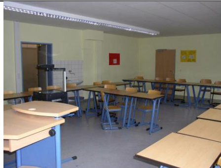
Abb. 2: Akustikdecke, geputzte Wände und Linoleum Fußboden; Foto: M. Buxtrup, UK NRW
