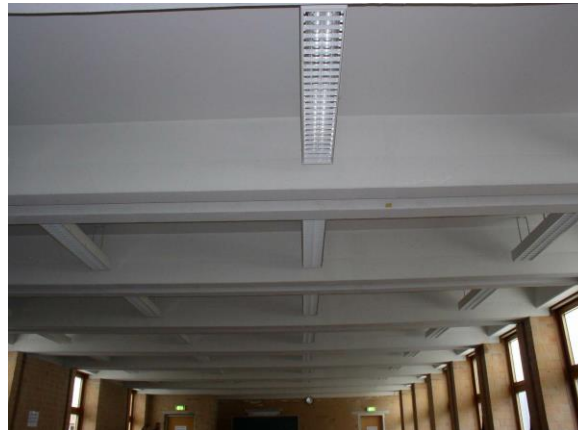
Abb. 11: Deckenstürze aus Beton. Foto: M. Buxtrup, UK NRW
